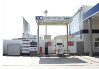
天然ガスステーション
