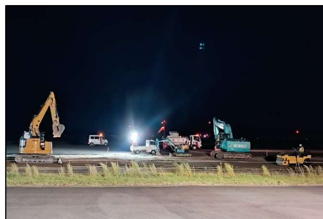
⑧'付近夜間工事風景 [9月末撮影]
