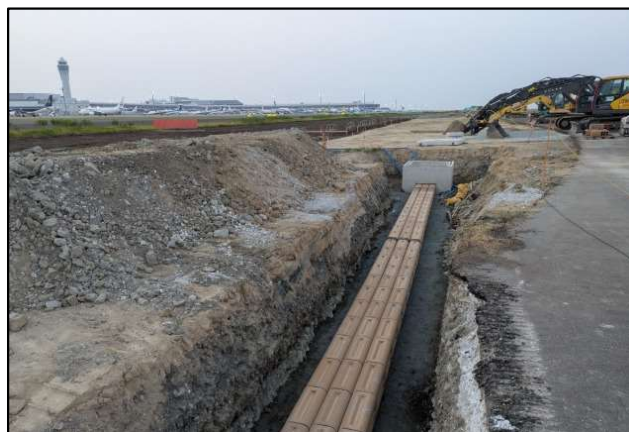
⑧'付近昼間工事風景 [9月末撮影]
