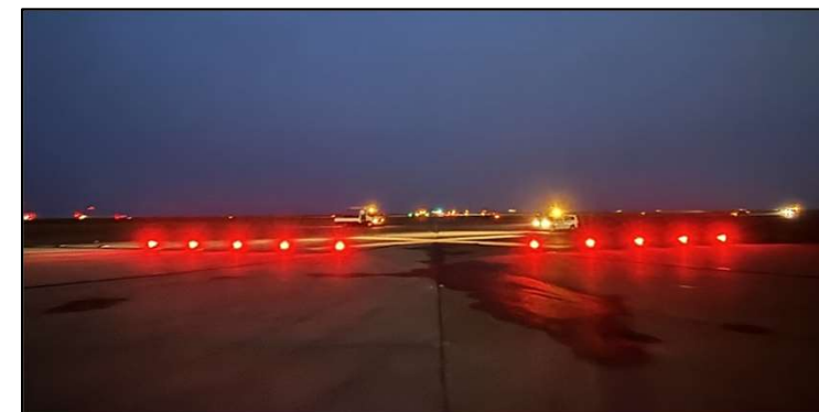
禁止標識、禁止区域灯の設置
