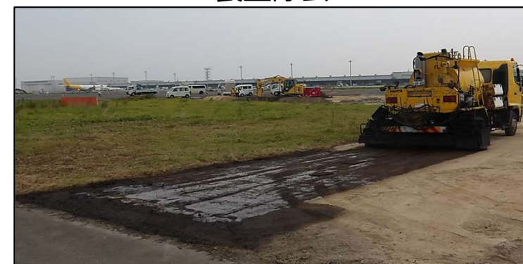
裸地へのアスファルト乳剤の散布 【環境保全措置】
