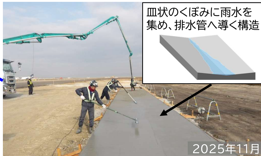
排水施設のコンクリート打設
