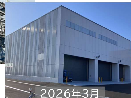
増改築した航空受配電所
