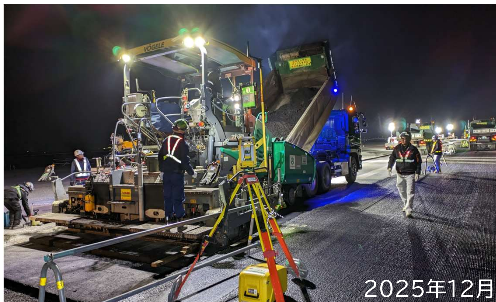
上層路盤のアスファルト舗装敷均し
