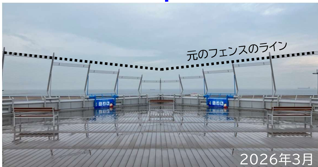
切り下げ後のスカイデッキフェンス (転移表面接触物件改修)
