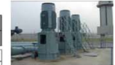
海水との温度差を利用し、プラント設備の冷却水を冷却
