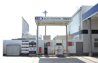
天然ガスステーション
