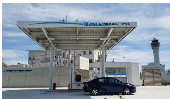
図 4.4-10 セントレア水素ステーション
