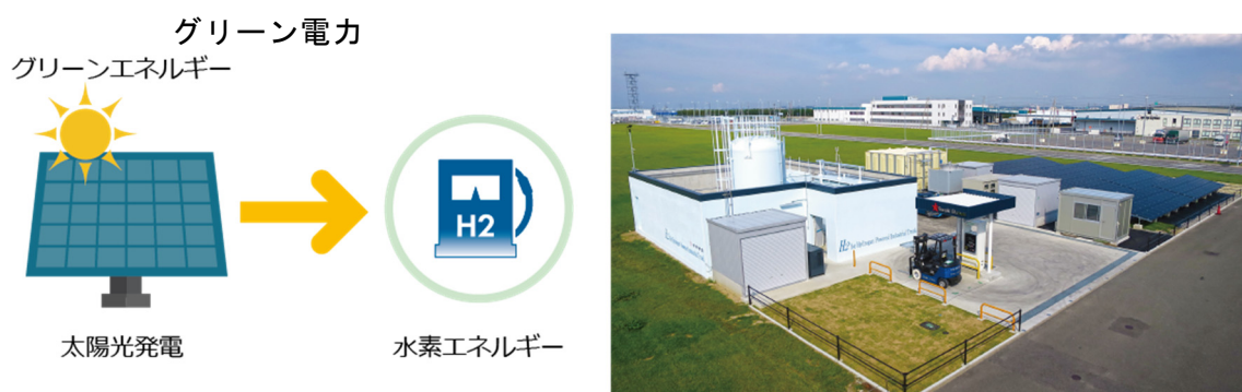
図 4.4-11 貨物地区水素充填所
