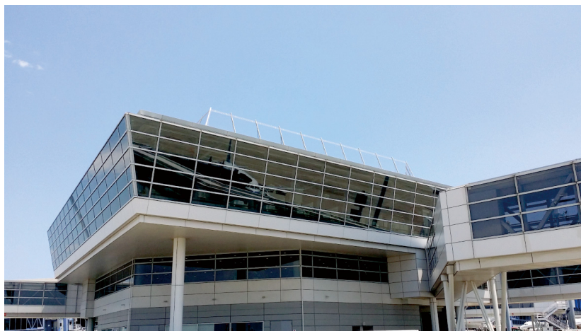
図 4.4-15 第1旅客ターミナルビルの光触媒ガラス
