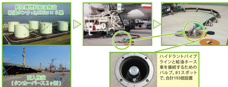
図 4.4-7 航空機燃料給油施設
