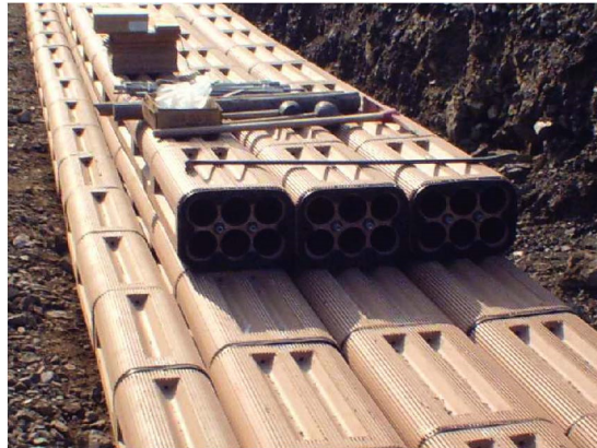
図 4.2-3 陶管を使用した灯火用埋設配管
