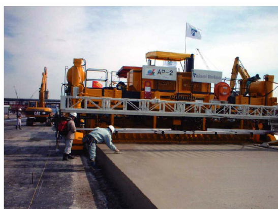
図 4.2-2 舗装工法・工事の状況
