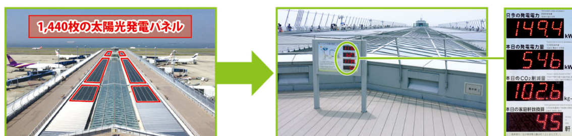
図 4.4-14 太陽光発電パネル、防眩型太陽電池モジュール
