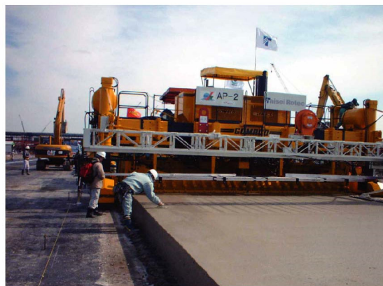
図 4.2-2 舗装工法・工事の状況
