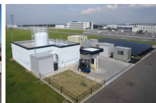
貨物地区水素充填所
