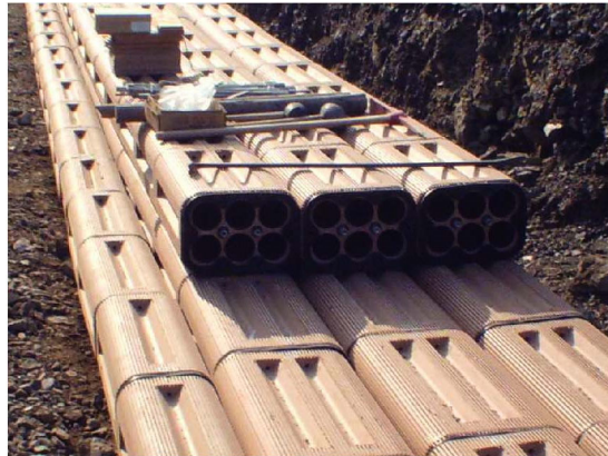
図 4.2-3 陶管を使用した灯火用埋設配管
