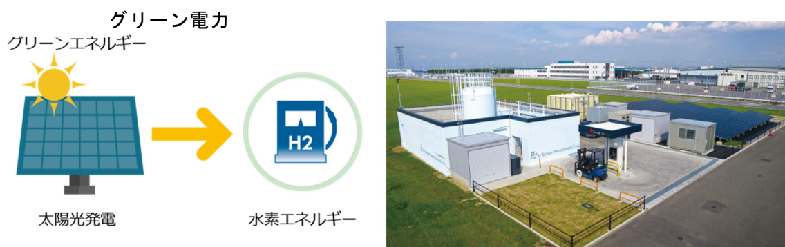
図 4.4-11 貨物地区水素充填所
