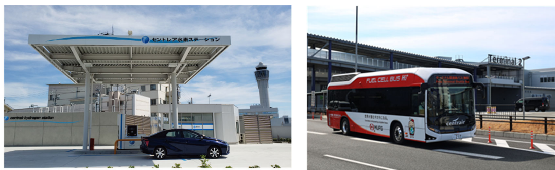
図 4.4-10 セントレア水素ステーション及びターミナル間連絡用燃料電池バス
