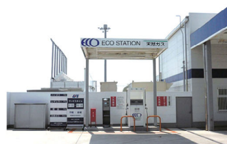
天然ガスステーション
