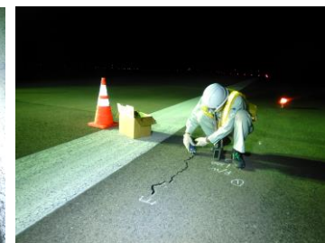
補修（シール注入）の様子
